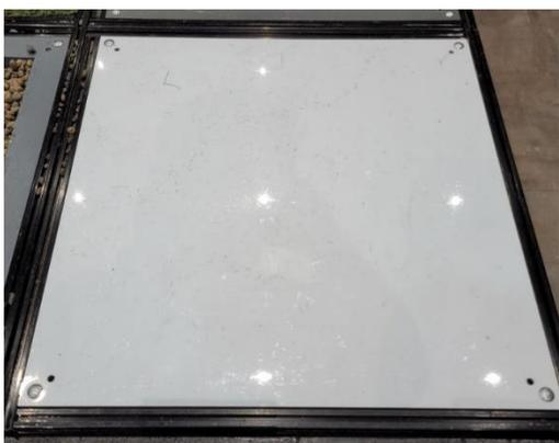
Скользкая поверхность (фторопластовая пластина). Для большей скользкости на поверхность может наноситься универсальная смазка WD-40.
